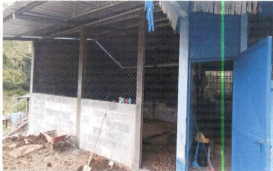
Foto 3: Area donde se contempla mejoramiento con estructura tipo potico e instalaciones de laminas troquelada calibre "26"
